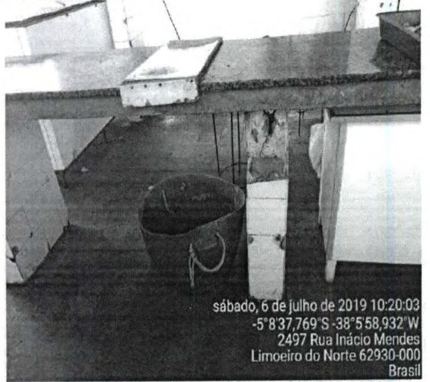
Foto 32 – Depósito de coleta de restos de carnes instalado em boxe.
