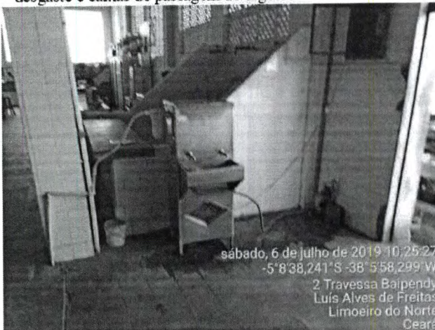
Foto 5 – Bebedouro apresentando elevado risco de contaminação.
