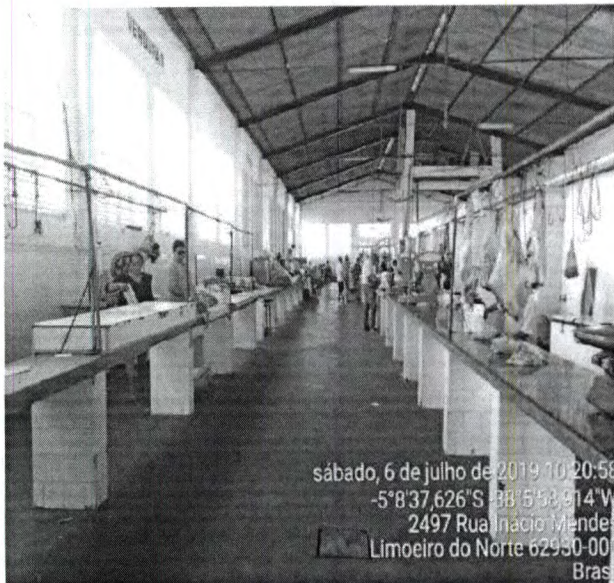
Foto 33 – Corredor dos boxes de venda de carnes, nenhuma refrigeração.
