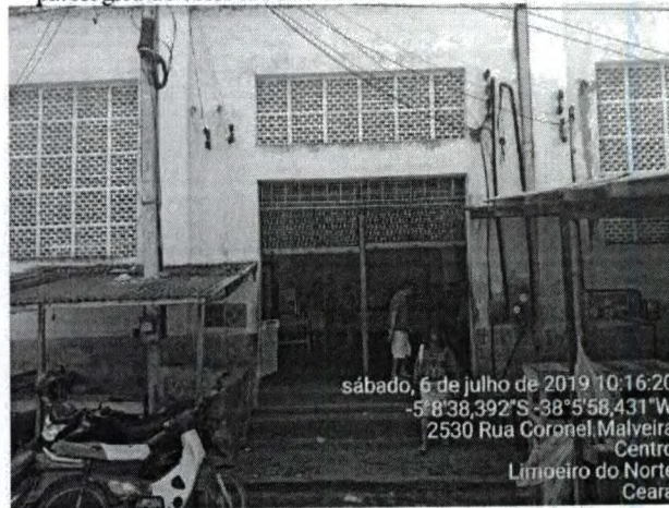
Foto 16 – Vista do Acesso lateral ao Mercado de Carnes e Peixes.
