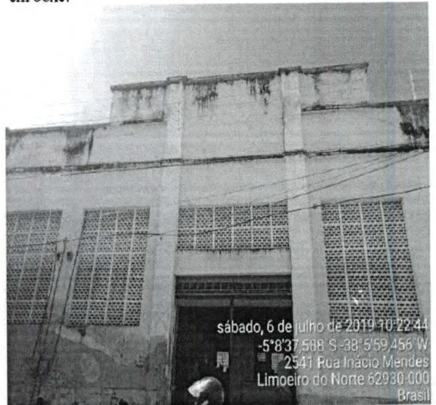
Foto 34 – Vista da fachada de fundo do Mercado de Carnes e Peixes.
