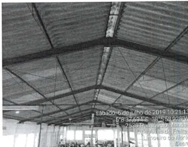
Foto 4 – Coberta em estrutura metálica e telhas de fibrocimento.
