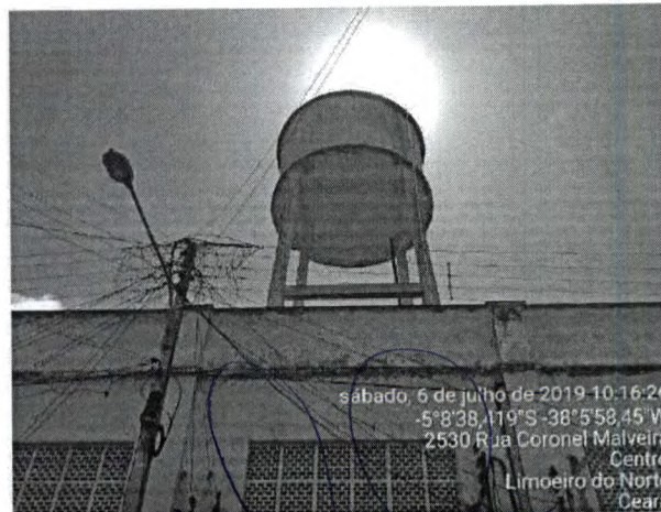
Foto 24 – Reservatório em concreto armado sem uso, previsão de demolição.
