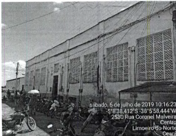
Foto 19 – Lateral do Mercado de Carnes e Peixes, detalhe das inúmeras ligações de energia elétrica.
