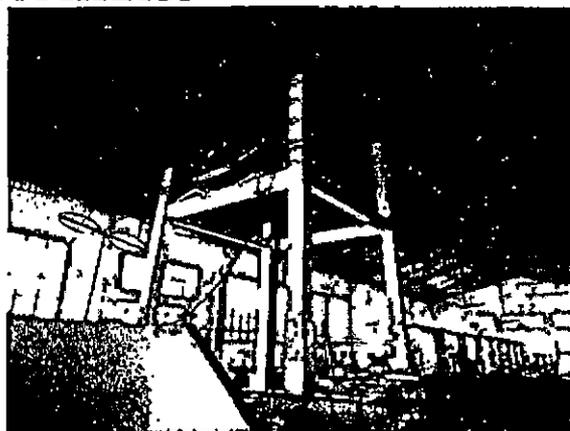
Foto 14 – Reservatório apoiado fundo e vista da estrutura da cobertura em telhas de fibrocimento.
