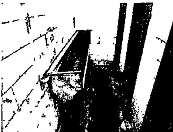
Foto 33 – Revestimento cerâmico desgastado e instalações hidráulicas inadequadas.
